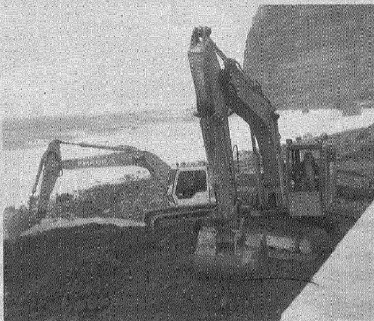
Em causa o desassoreamento na foz da ribeira da Madalena do Mar.
